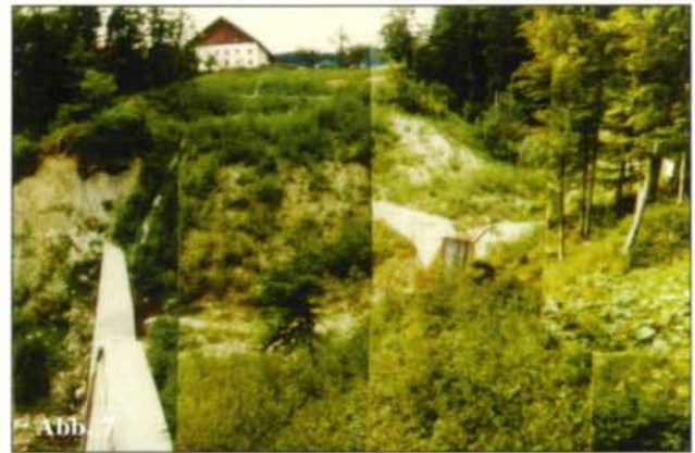
Abb. 5: Konsolidierung einer labilen Grabenstrecke (Erosions­feile) durch Rundholzsperrn und anschließender Aufforstung mit standortgerechten Baumarten (Schobergräben, St. Lorenz).
