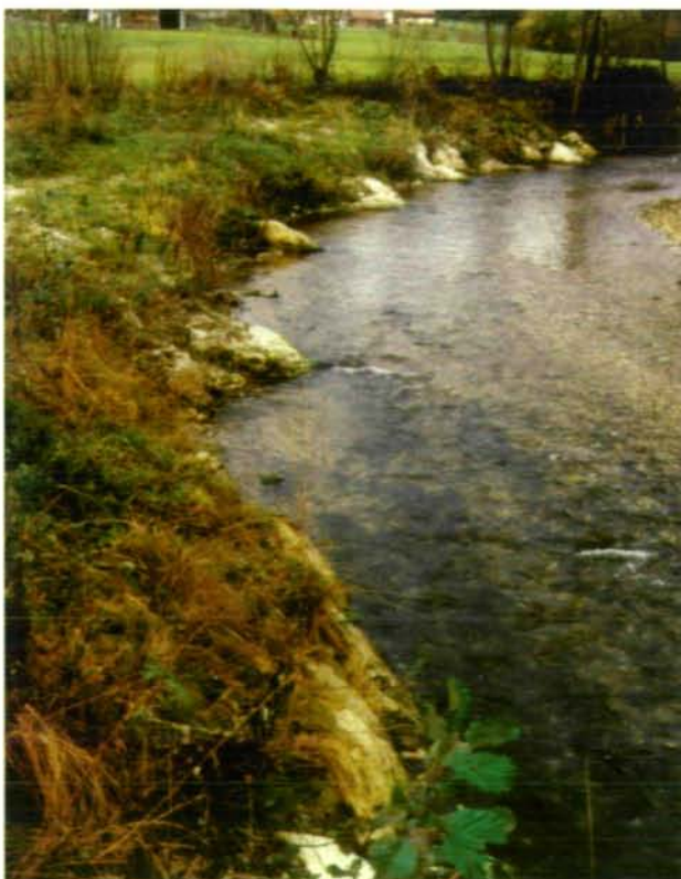
Abb. 12: Ufersicherung durch Grobsteinbühnen und Lebendbauweisen - Zustand 1991 (Redlbach, Gemeinde Fornach).
