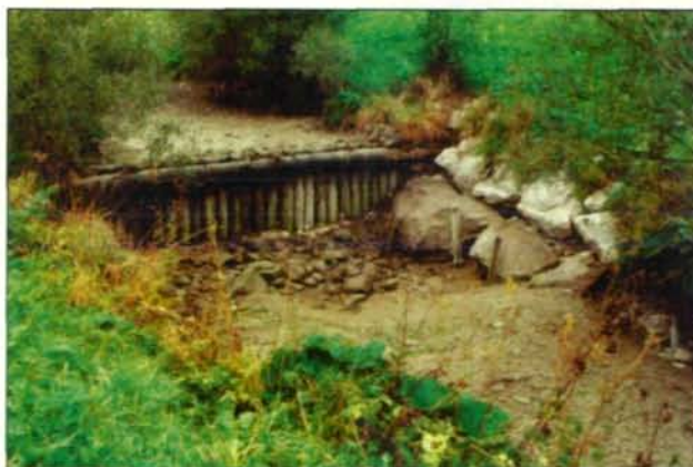
Abb. 16: Umgestaltete Sohlschwelen im trockenengefallenen Bachbett des Spranzlbaches im August 1992; tiefe Kolkwanne mit deutlich erkennbarer Kornsortierung; die Grobsteinschichtung beschränkt sich auf den Bereich der Kolkwanne.
