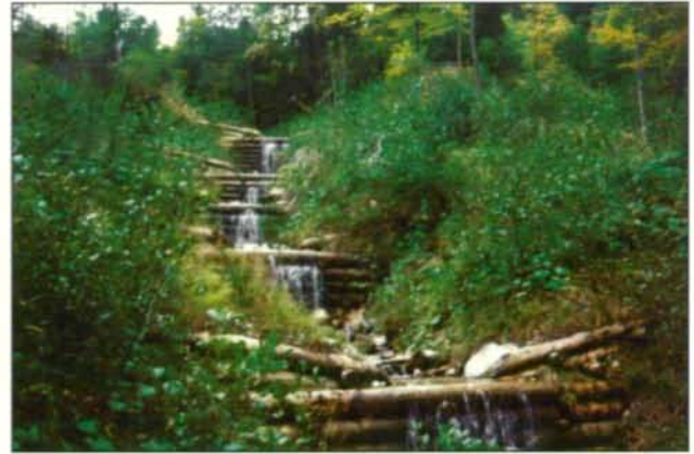
Abb. 5: Konsolidierung einer labilen Grabenstrecke (Erosions­feile) durch Rundholzsperrn und anschließender Aufforstung mit standortgerechten Baumarten (Schobergräben, St. Lorenz).
