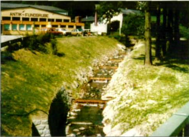
Abb. 19: Der Zustand am Fallaubach nach Abschluß der Verbauungsmaß- nahmen (rauhe Steinsätze mit Asteinlagen, Solestrukturie- rung, niedere Rundholzsohl- schwellen).
