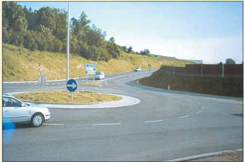
Abb. 4: Der Kreisverkehr in Ebelsberg bildet den Ausgangspunkt der Umfahrungsstraße Ebelsberg.
