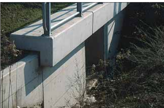
Abb. 12: Leistungsfähige Kleintierdurchlässe mit Leiteinrichtungen erhalten die ökologische Verbindung zwischen VÖEST- und ÖBB-Gelände.
