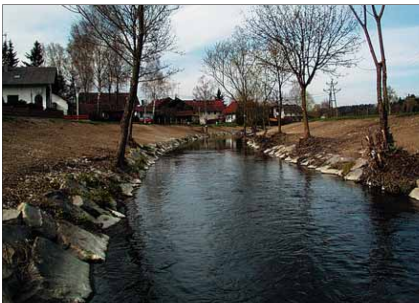
Abb. 2: Wasserbau wie vor 30 Jahren: die Bilder wurden im April 2000 aufgenommen. Alle Fotos sind vom Autor.
