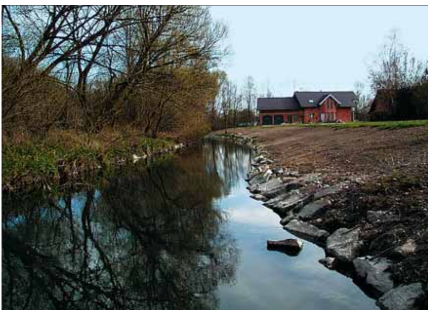
Abb. 4: 30 Jahre alter Bewuchs am linken Ufer, am rechten Ufer wurde der Zustand wie nach der Regulierung 1969 wieder hergestellt.
