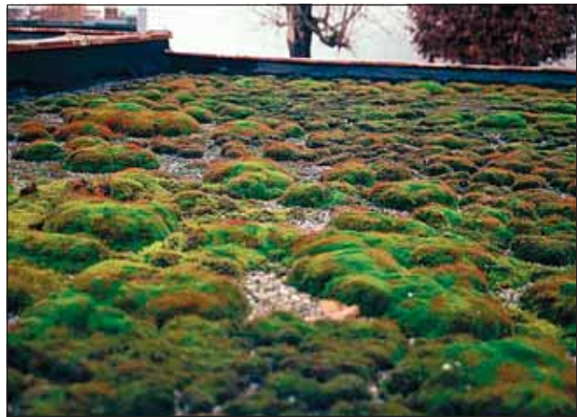
Abb. 5: Flachdach eines Neubaus: Geschotterte Flachdächer werden nach einigen Jahren reichlich von Moosen besiedelt. Sie haben keinen negativen Effekt für die Bauten und sind Heimat einer reichen Welt an Kleintieren (z. B. Bärtierchen).
