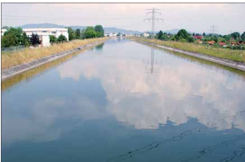
Abb. 19: Der Oberwasserkanal des Kraftwerks Kleinmünchen, auch genannt Jaukerbach, ist ein abschreckendes Beispiel des technokratischen Wasserbaustils der 1970er-Jahre: Eine aus der Landschaft herausgehobene, betonierte Wasserrinne, völlig struktur- und gesichtslos, die lediglich dazu dient, das Traunwasser der Turbine zuzuleiten. Foto: G. Laister
