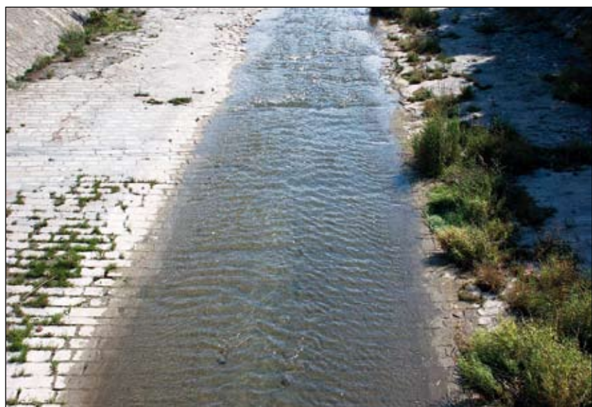
Abb. 6: In diesem Abschnitt des Wienflusses (nahe Hütteldorf, Wien) findet sich kaum natürliches Sediment. Folglich ist hier auch mit wenig Selbstreinigung zu rechnen.
