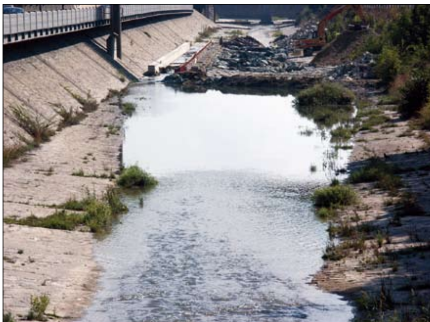
Abb. 1: Dient das Renaturieren von Flüssen wirklich nur unseren ästhetischen Ansprüchen? Oder liegt viel mehr Bedeutung in der natürlichen Gestaltung unserer Fließgewässer ... In der Nähe von Hütteldorf (Wien) wurde ein kleiner Abschnitt des Wienflusses renaturiert. Die großen Blocksteine wurden durch natürliches Sediment ersetzt. Auf dem Photo sieht man im Hintergrund die Bauarbeiten.
