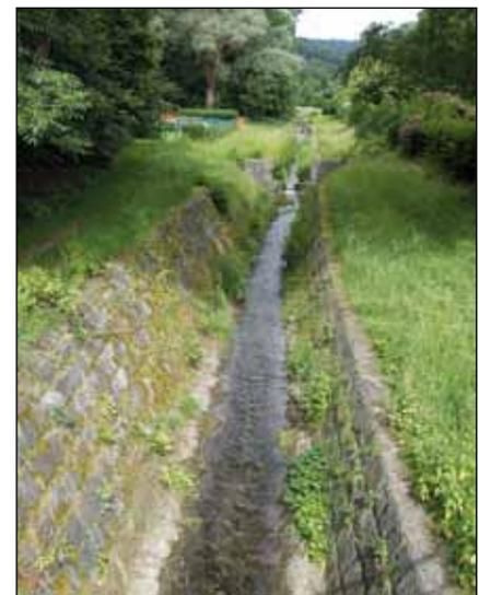
Abb. 1: Der Höllmühlbach wirkt im unteren Abschnitt eher kanalartig: einheitliches Trapezprofil Sohle, Ufer und abgesetzte Sohlstufen gepflastert. Zur Zeit der Errichtung standen der Schutz vor Grundwasserverunreinigung und der technische Hochwasserschutz im Mittelpunkt. Auf ökologische Zusammenhänge wurde damals noch weniger geachtet.
