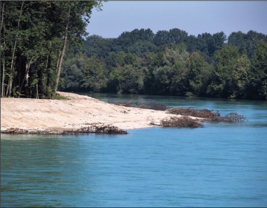
Abb. 24: Ausblick: Unterm Kraftwerk Mühlrading wurde ein Steilufer in ein über und unter Wasser lebensfreundliches Kiesufer umgewandelt (Punkt 15 in Abb. 16). Wie bei einer Reihe anderer positiver Maßnahmen erfolgte die Umsetzung durch die Ennskraft-AG. Weiter so, wünscht sich die Enns!
