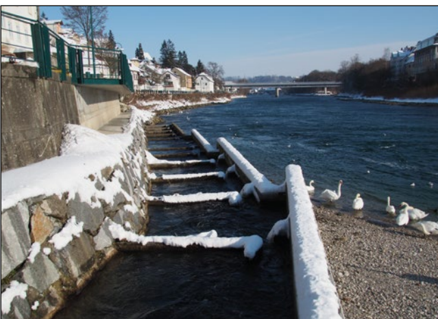
Abb. 12: Technische Organismenwanderhilfe am Spitalmühlwehr (Mündung der Steyr in die Enns). Der größte Zielfisch bestimmt die Größe der Anlage: Für den Huchen sind recht beträchtliche Maße erforderlich.
