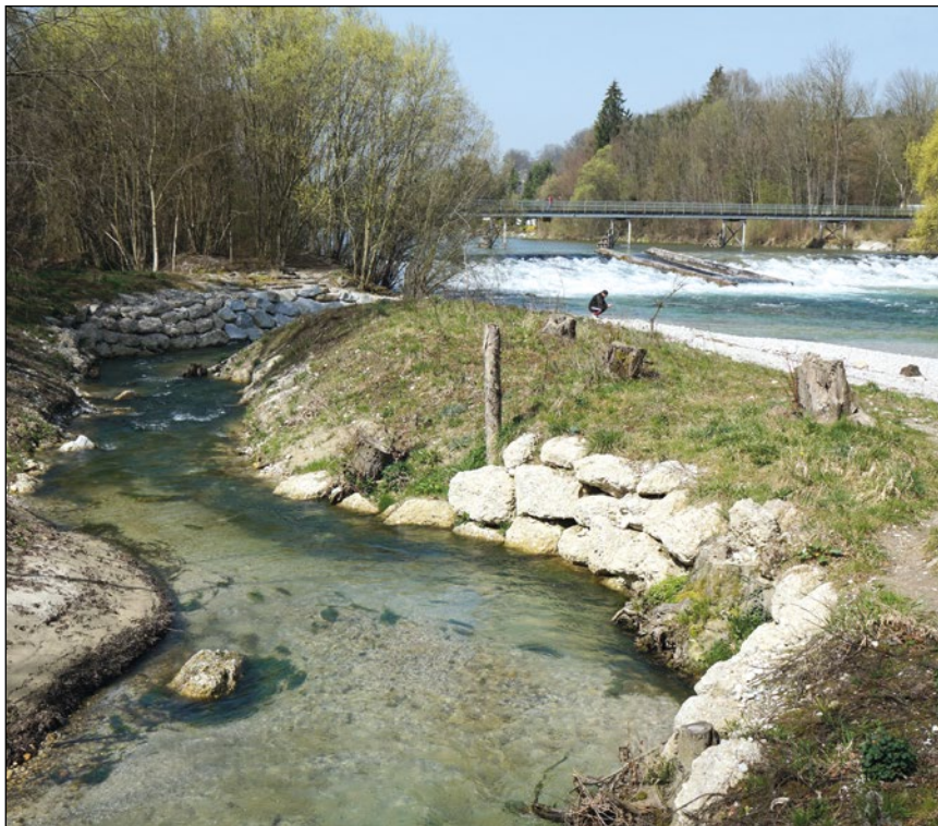
Abb. 23: Ein naturnah ausgeführtes Umgehungsgerinne ist immer erfreulicher als eine technische Organismenwanderhilfe (vgl. Abb. 12), außerdem meist weit billiger. Platz muss halt verfügbar sein. Auf dem Bild sieht man den unteren Abschnitt des Gerinnes, der wieder ans Wehr heran verschwenkt wird, um dort, in der Nähe des Wanderhindernisses, die entsprechende Lockströmung anzubieten, die den Fischen den Weg weist. Das Wehr selber, im Bildhintergrund, ist auch nach dem Neubau als Steinrampe nur für die „allersportlichsten“ Fische passierbar gewesen. Foto: Clemens Ratschan
