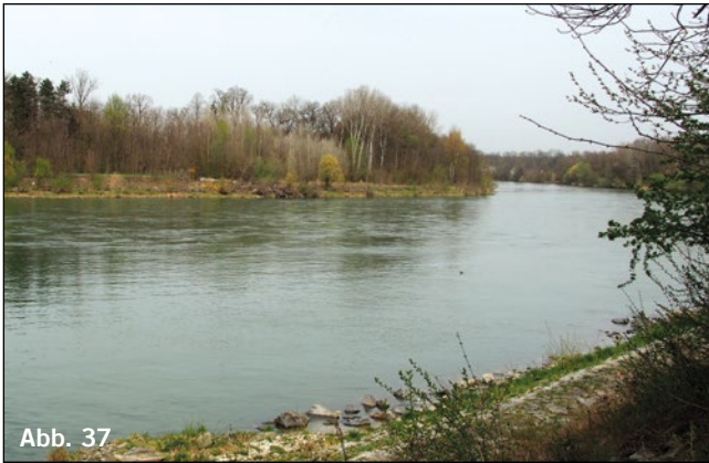
Abb. 37 (5. 4. 2016) und 38 (27. 8. 2016): Vorher ein Steilufer, im oberen Teil mit Blockwurf. Der steile Abfall setzte sich auch unter der Wasseranschlagslinie bis in zwei, drei Meter Tiefe fort. Nachher: Auf 600 Metern Länge wurde ein über und unter Wasser sanft abfallendes Kiesufer hergestellt. Das Material im ehemaligen Steilufer musste dazu überwiegend nur umgelagert werden, was zu den relativ geringen Kosten entscheidend beitrug. Die Baggerfahrer arbeiteten genau, um die berechneten Profile herzustellen. Den Feinschliff erhält die Ausformung des Geländes dann durch die Kräfte der Natur, vgl. Abb. 39! Neben der Funktion als Kieslaichplatz ist hier auch ein menschenfreundliches Flachufer entstanden, wo die Enns, ehemals das Sommerparadies der Einheimischen, wieder zugänglich und einladend ist.
