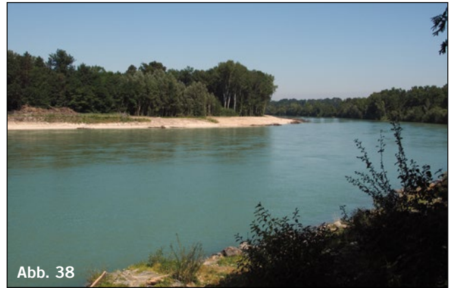
Abb. 37 (5. 4. 2016) und 38 (27. 8. 2016): Vorher ein Steilufer, im oberen Teil mit Blockwurf. Der steile Abfall setzte sich auch unter der Wasseranschlagslinie bis in zwei, drei Meter Tiefe fort. Nachher: Auf 600 Metern Länge wurde ein über und unter Wasser sanft abfallendes Kiesufer hergestellt. Das Material im ehemaligen Steilufer musste dazu überwiegend nur umgelagert werden, was zu den relativ geringen Kosten entscheidend beitrug. Die Baggerfahrer arbeiteten genau, um die berechneten Profile herzustellen. Den Feinschliff erhält die Ausformung des Geländes dann durch die Kräfte der Natur, vgl. Abb. 39! Neben der Funktion als Kieslaichplatz ist hier auch ein menschenfreundliches Flachufer entstanden, wo die Enns, ehemals das Sommerparadies der Einheimischen, wieder zugänglich und einladend ist.
