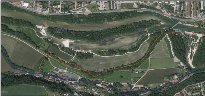
Abb. 3: (23. 6. 2016) Der neue Seitenarm, in dem sich das Geschiebe ablagert (angestrebte Quote: 85 % der Gesamtmasse): 1: Streichwehr am oberen Ende. 2: Sohlgurt in der Steyr, der das Geschiebe in den Nebenarm leitet. Er endet wenige Meter vor dem linken Ufer, da er sonst bei Niederwasser ein Wanderhindernis für Organismen wäre. Die entstandene Insel ist an beiden Enden durch Brücken erschlossen. Ein neu angelegter, breiter Fahrweg führt entlang des südlich anschließenden Auehölzles. 3: Der sogenannte Steinkasten, Streichwehr, das bei Hochwässern massiv überströmt wird. 4: Besonders wertvolle Schotterflächen mit Pioniervegetation um die Insel bei St. Anna. Sie brauchen, wie auch andere Strukturen am und im Fluss, einen gewissen Geschiebenachschub! Dunkelblaue Linie: Himmlitzer Bach, beim Kruglwehr abzweigender, alter Wehrbach. Gelbe Linie: der revitalisierte Dreihansl bach (vgl. unten, Maßnahme 4).
