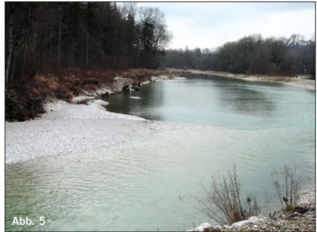
Abb. 4 (21. 6. 2011) und 5 (25. 1. 2012): Im Geschiebefang bilden sich nach Hochwässern Kiesbänke, zunächst natürlich im oberen Teil. Bisher werden sie leider lang bevor auch der untere Teil mit Schotter gefüllt ist, abgebaggert. In Abb. 5 ist die Reduktion der Schotterfläche, die Eintiefung und das Verschwinden der reizvollen Furtsituation erkennbar.
