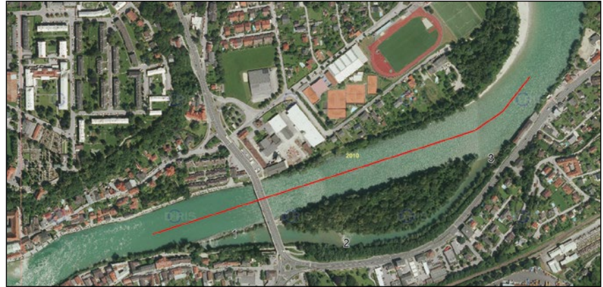
Abb. 23: a. Zu Maßnahme 9, Bild vor Entfernung des Leitdamms zur Rederinsel. 1: 2010 entfernter Leitdamm. 2 und 3: Kleinere Querbauwerke, die ebenfalls entfernt wurden. Schon die Entnahme des Damms allein senkte den Wasserspiegel im Hauptbett stark ab, weil der Nebenarm ca. 1,5 Meter tiefer lag. b. Maßnahme 10: Die rote Linie gibt den Bereich an, in dem die Flusssohle tiefer gelegt wurde. Die Absenkung betrug bis zu 2,7 Meter und auf gut 50 % der Strecke über zwei Meter. Die Rederbrücke liegt am linken, oberen Ende der Insel. Maßnahme 11 ist zum Aufnahmezeitpunkt schon ausgeführt.
