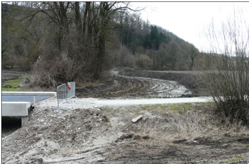
Abb. 9: (März 2009) Die größte Baustelle für die Wiederherstellung des Dreihansbachs war die Errichtung der kleinen Brücke links im Bild. Das Einlaufbauwerk aus dem Himmlitzer Bach wurde auch neu gemacht. Die Geländemulde für den Bachlauf war noch vorhanden und musste nur etwas ausgeräumt werden. Die neuen Ufer bewuchsen sich sehr schnell. Heuer fand ich im Wasser um diese Brücke einen schönen Bestand von Bach-Ehrenpreis ( Veronica beccabunga ) und Haar-Hahnenfuß ( Ranunculus trichophyllus ssp. trichophyllus ), nebst der Kanadischen Wasserpest.
