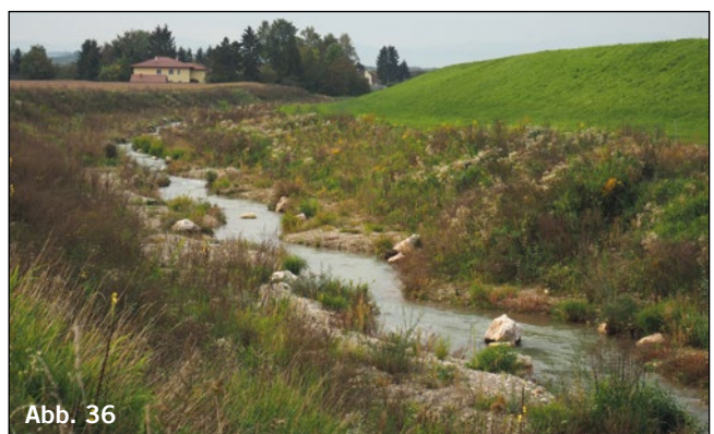
Abb. 35 (Mai 2015) und 36 (September 2017): Rechts hinter dem Damm liegt, höher als das Umland, der Stausee. Der begleitende Sickerwassergraben wurde für den Bachlauf stark umgestaltet. Eine Anmerkung: Fließgewässer sind besonders „dankbar für Renaturierungen“. Es gibt „nachtragendere“ Lebensräume (trockengelegtes Moor, einmal überdüngte Magerwiese...).
