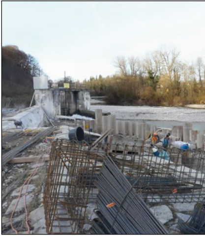
Abb. 15: Maßnahme 6, Errichtung der Organismenwanderhilfe am Kugelfangwehr: Da wird ordentlich „Hardware“ verbaut. Kein Wunder, dass naturnahe Umgehungsgerinne meist wesentlich billiger sind. Hier war aber laut Experten nicht genug Platz für ein solches (Lage: Ziffer 3 in Abb. 16).
