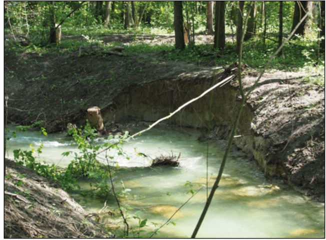
Abb. 12: Das Umgehungsgerinne fürs Annawehr ist mehr als ein „Fischaufstieg“: Kaum angelegt, arbeitet der Bachlauf schon selber an seiner noch natürlicheren Ausgestaltung. Man erkennt einen frischen Uferanriss im Ausand.
