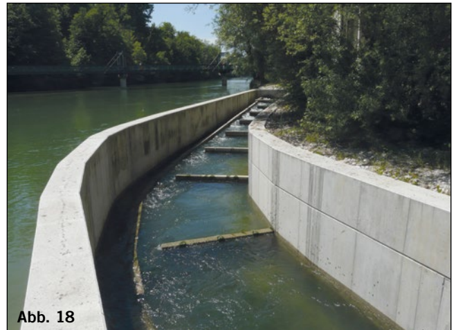
Abb. 17: Haindmühlwehr kurz oberhalb der Einmündung der Steyr in die Enns, links im Bild der Fischaufstieg. Turm des Bürgerspitals und die Zwiebeltürme der Michaelerkirche. Die Brücke im Bild liegt unmittelbar oberhalb der Mündung der Steyr in die Enns. Abb. 18: Die Größe der Becken des Fischaufstiegs ist für den bis 1,3 Meter langen Huchen ausgelegt. Die Position der Anlage ist auch in Abb. 19 angegeben.
