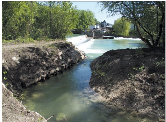
Abb. 14: Rückmündung in die Steyr unterhalb des Annawehrs, zugleich Einstieg für die Laichwanderungen. Früher beobachtete ich immer wieder Fische, die nach Überwinden der unteren Wehrstufe an der oberen vergeblich emporsprangen. Zur Lage der Lockströmung: Wenn die Fische quer am Hindernis entlang suchen, werden sie zum Einstieg geführt.
