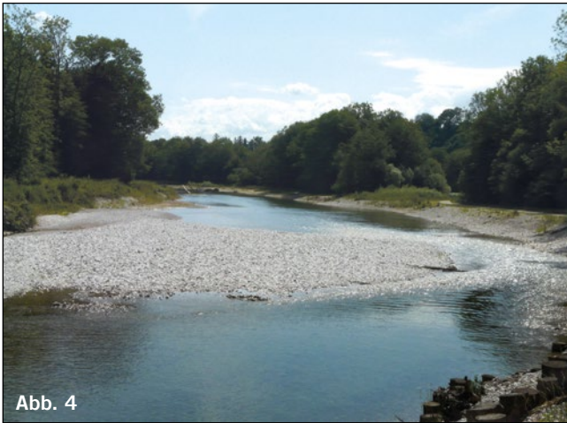
Abb. 4 (21. 6. 2011) und 5 (25. 1. 2012): Im Geschiebefang bilden sich nach Hochwässern Kiesbänke, zunächst natürlich im oberen Teil. Bisher werden sie leider lang bevor auch der untere Teil mit Schotter gefüllt ist, abgebaggert. In Abb. 5 ist die Reduktion der Schotterfläche, die Eintiefung und das Verschwinden der reizvollen Furtsituation erkennbar.
