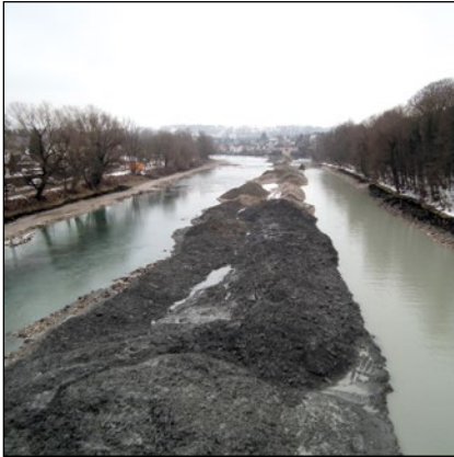
Abb. 22: (11. 1. 2011) Massive Baggerungen in der Enns bei der Rederinsel (Maßnahme 10; der in den Medien kolportierte „Fels“ war, wie im Bild ersichtlich, überwiegend Schlier).
