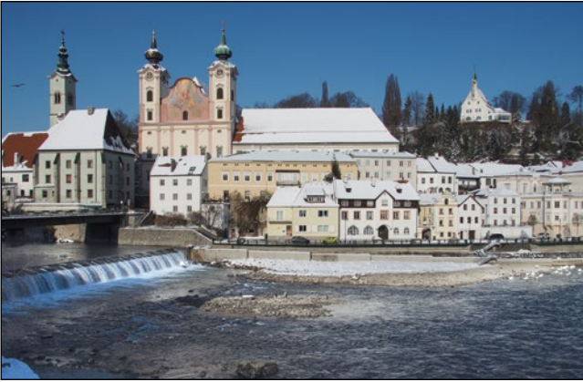
Abb. 20: Das Spitalmühlwehr unmittelbar an der Mündung der Steyr in die Enns und die Organismenwanderhilfe, die die Steyr aus der Enns zugänglich macht – eine besonders wichtige Anlage. Das Bild belegt meines Erachtens, dass die Aufregung über die Auswirkungen aufs Stadtbild überflüssig war! Man muss genau hinsehen, um die Anlage zu erkennen. Links Bürgerspital, Bildmitte Michaelerkirche, oben am Abhang der „Taborturm“. (Detailabbildung in (ÖKO-L 3/2017).
