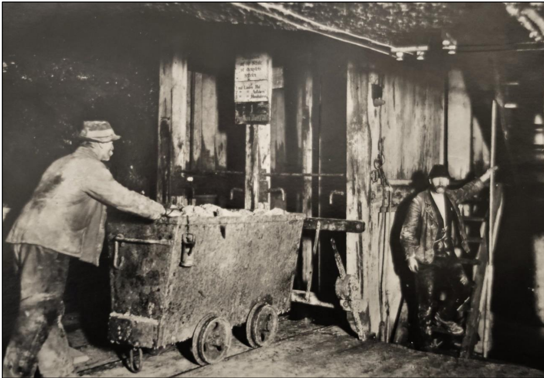
Abb. 18: Füllort am Distlerschacht, I. Tiefbau 1920 Archiv ÖSAG
