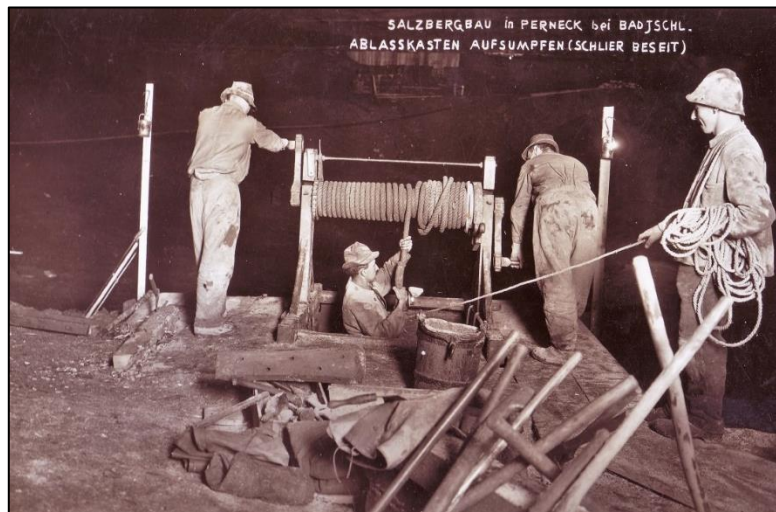
Abb. 7: Absumpfen eines Ablasskastens, Bergbau Ischl, Foto von Hans Köberl um 1935, Archiv Salinen Austria AG
