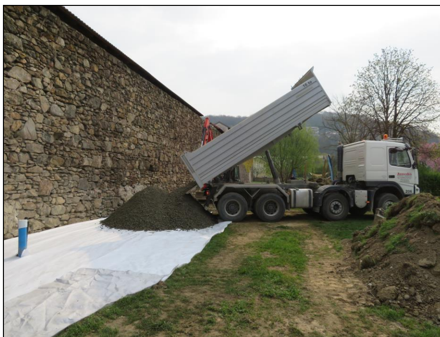
Abb. 3: Herstellung des tragfähigen Untergrundes.
