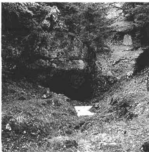
Das untere Braunsteinvorkommen auf 1.150 m Seehöhe. Ein großer, abgesackter Felsblock verschließt das Stollenmundloch.
