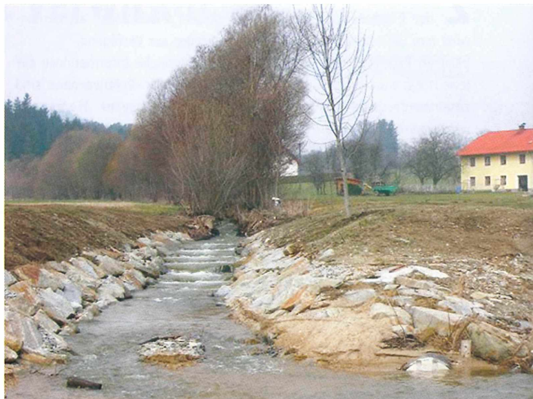
Lesterbachmündung nach dem Umbau. Der Aufstieg der Fische ist wieder gewährleistet.
