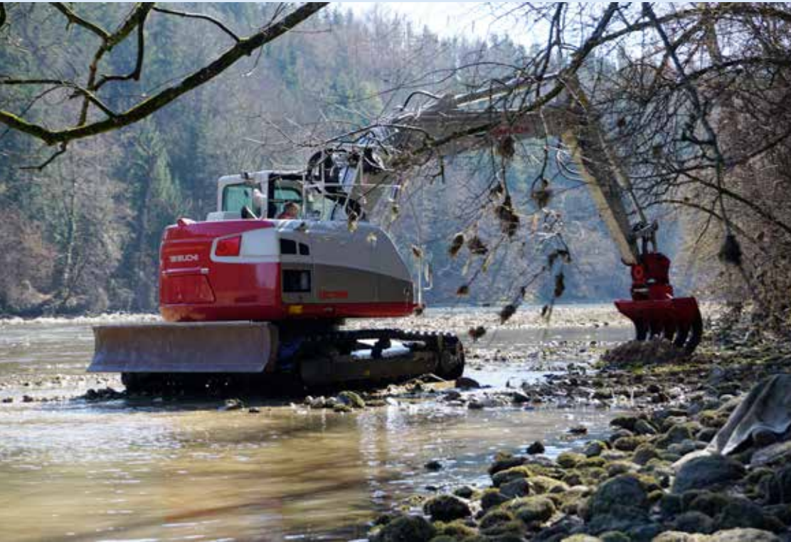
Laichplatzaufbereitung mit Bagger und Roderechen
