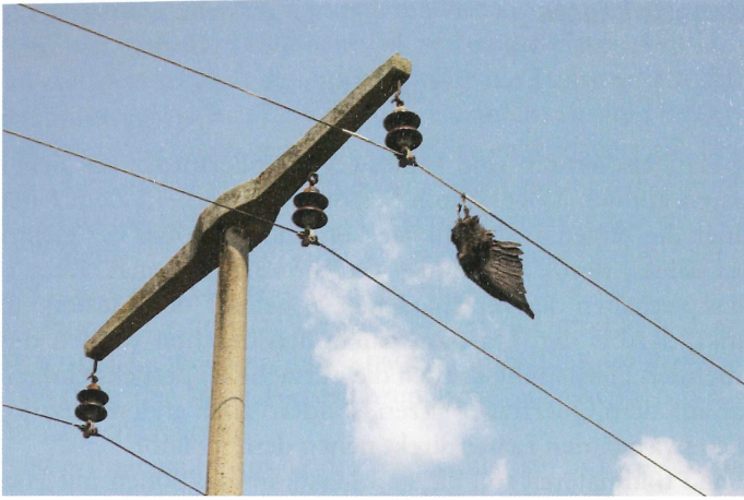
Abb. 2: Dieser Kolkkrabe ( Corvus corax ) konnte, von seinem Sitzplatz auf dem Stromleiter aus, leicht den kurzen Isolator überbrücken. Nach dem Stromschlag blieb er festgeschmort hängen und wurde vom Wind etwas von der Unfallstelle wegeweht. Der verschmorte, aufgeplatzte Fang schließt sich wie ein „Ring“ um den Draht. Landkreis Oder-Spree, Brandenburg, 07.07.2006, Fund und Foto: Daniel Schmidt
