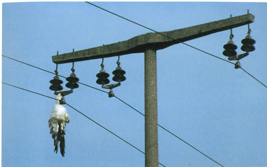
Abb. 1: Dieser junge Mäusebussard konnte mit seinem Körper leicht die sehr kurzen Hängeisolatoren überbrücken und blieb nach dem Stromschlag hängen, mit einem Fang festgeschmort am Verbindungsstück der Hängeisolatoren. Darchau (Niedersachsen), 30.8.2002. Fund und Foto: G. Fiedler
