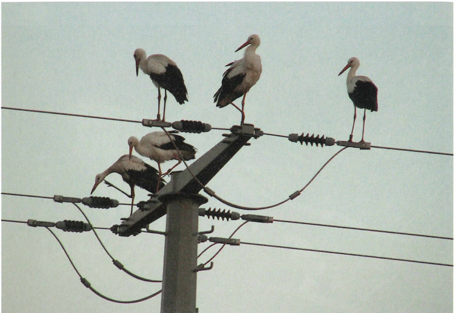
Abb 1 a: Durchziehende Störche ( Ciconia ciconia ) lassen sich im Spätsommer 2005 bei Bösleben im Ilmkreis/Thüringen zur Rast nieder. Drei Störche landen auf der Traverse des aus gut leitendem Metall konstruierten Mastens, zwei weitere landen aber auf den breiten Befestigungselementen der Leiter. Die drei Vögel im Vordergrund müssen friedlich bleiben: jede ansonsten harmlose Rangelei mit Schnabel- oder Flügelkontakt führt unweigerlich zum Stromschlagunfall der beteiligten Vögel.
