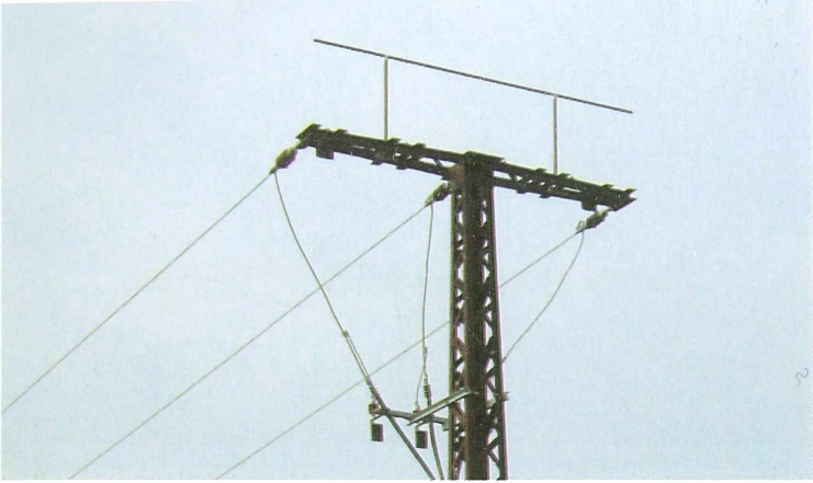
Abb. 6: Auch dickere Sitzstangen als die in Abb. 4 gezeigte erreichen nicht die hohe Sicherheit von soliden Isolationsmaßnahmen wie in Abb. 5 dargestellt. An diesem Mast fand Dr. Torsten Langgemach am 13.12.2006 einen durch Stromschlag getöteten adulten Mäusebussard ( Buteo buteo ). Dieser Mast ist weiterhin hoch-gefährlich. Foto: Birgit Bock
