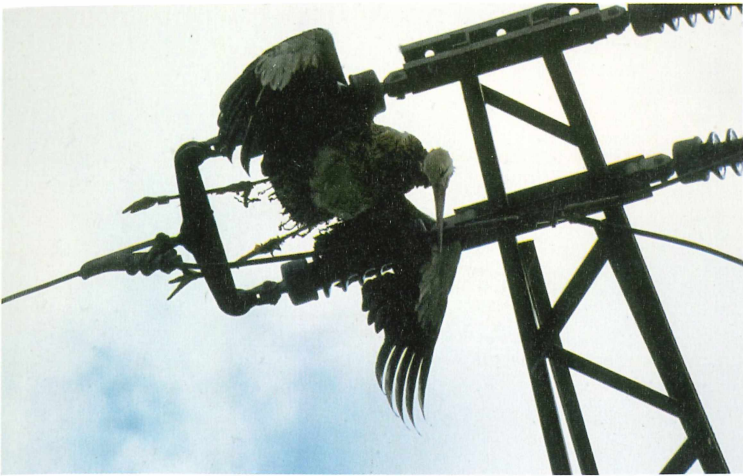
Abb. 3: Auch dieser stromtote Storch ( Ciconia ciconia ) hat wohl vom Verbindungsstück aus den Isolator überbrückt (leider liegt kein Befundprotokoll des geborgenen Vogels vor). Zu beachten sind hier die ausgedehnten Verbrennungen 4. Grades zwischen den Stromeintrittsstellen (beide Läufe) und Austrittsstellen (Flügelbug links). Wörth, Baden-Württemberg, 19.6.1995. Bericht und Foto: Walther Feld
