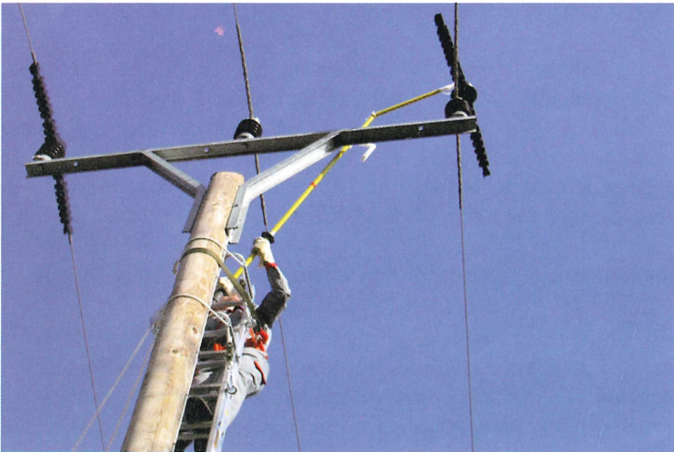
Abb. 1: Arbeiten unter Spannung: Aufsetzen der Vogelschutzhauben. Quelle: BSD
