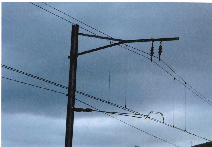
Abb. 4: Fahrleitungsmast, der durch seine großen Isolatoren den unter Spannung stehenden Leitungsbereich relativ gut abschirmt und einen relativ gefahrenarmen Rastplatz für Vögel auf der Mastspitze bietet. Schweiz, Juni 2006. Foto D. Haas
