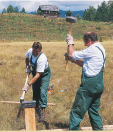
Errichtung der ersten Holzdämme am Überling
