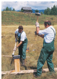
Mitarbeiter des Forstbetriebs Tamsweg beim Dammbau
