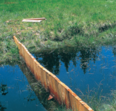
Erfolgreicher Einstau im Entwässerungsgraben
