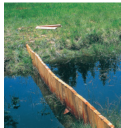
Einstau im Entwässerungsgraben
