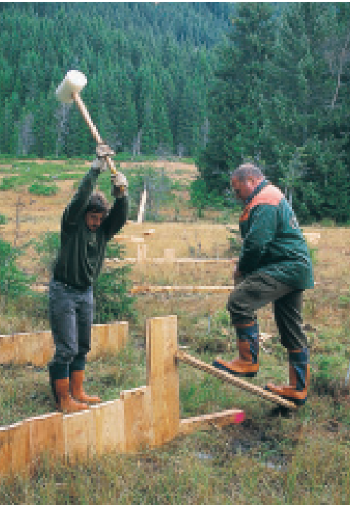
Im Wasenmoos wurden breitere Holzpfosten als in anderen Mooren verwendet
