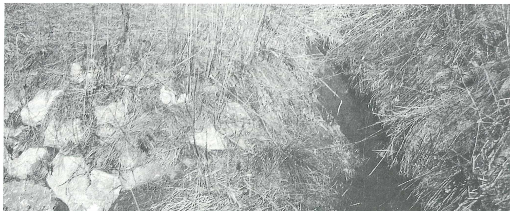
Abb. 7: Entwässerungsgraben bei Schiefer
