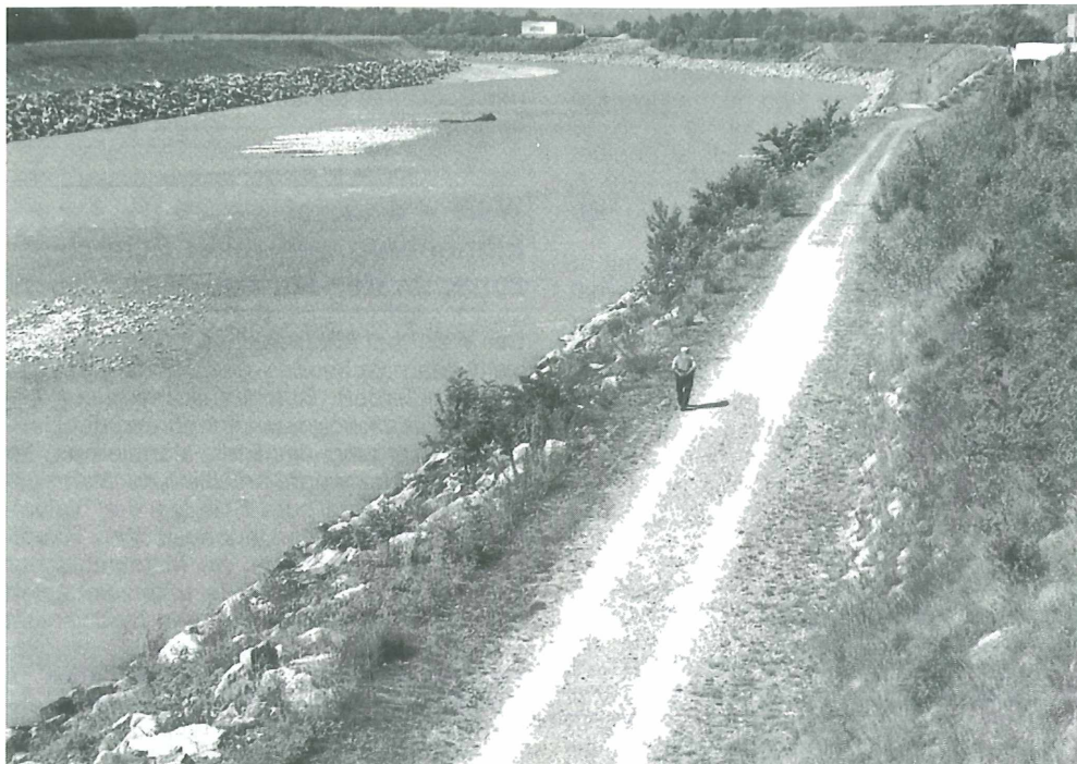
Der kanalartig regulierte Alpenrhein zwischen der Schweiz, Liechtenstein und Vorarlberg soll nach einem gemeinsam erarbeiteten Projekt langfristig revitalisiert und fischökologisch verbessert werden.
