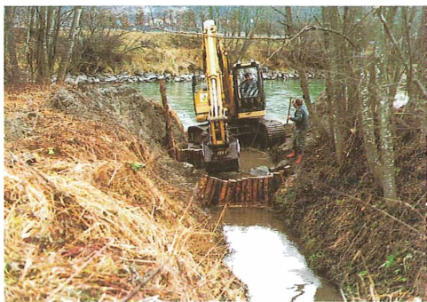
Bagger im Einsatz, der innerhalb der späteren Fischtrappe die Buchten gestaltet
