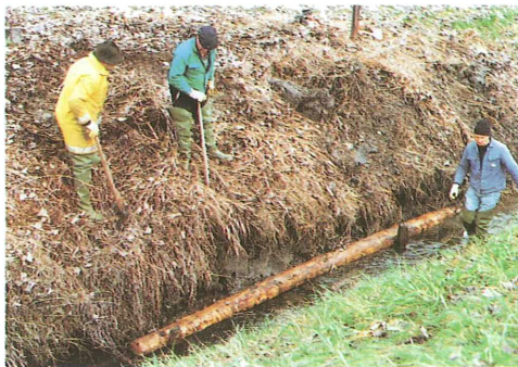
Der Bautrupp der Tauernkraft sichert das abruttschende Bachufer mit Lärchenstämmen
