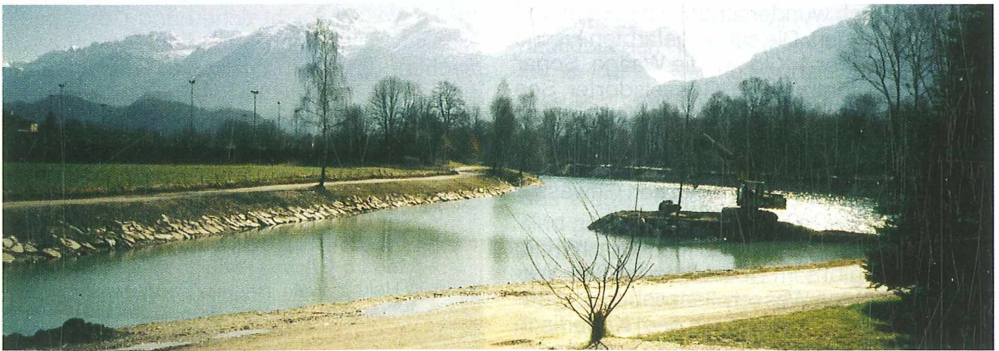
Eine künstliche Insel bereichert den Bürgerausee in Kuchl seit dem Frühjahr 1998. Der See wurde durch Ausbaggern auf doppelte Tiefe gebracht (von 2 auf 4 m). Die Wasserqualität nimmt dadurch zum Vorteil der Fische zu. Die kleine Insel gibt dem Baggersee eine Struktur. HOT
