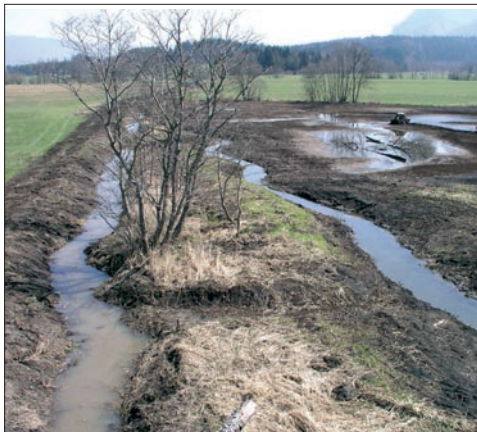
Restrukturierter Teilabschnitt des Moosbaches im März 2003. Links das bestehende Gerinne, das naturnah umgestaltet wurde, rechts der neue Bachlauf, rechts hinten ein Teil der neuen Retentionsfläche Foto: © TB Petz OEG
