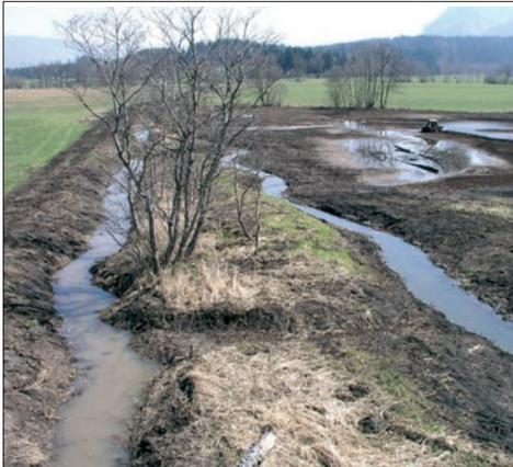
Restrukturierter Teilabschnitt des Moosbaches im März 2003. Links das bestehende Gerinne, das naturnah umgestaltet wurde, rechts der neue Bachlauf, rechts hinten ein Teil der neuen Retentionsfläche
