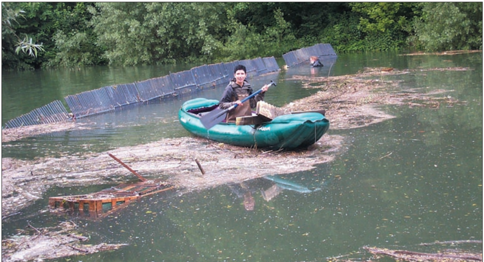
Abb. 11: Fischwehr an der Pielachmündung bei Donaueinstau im Jahr 2001
