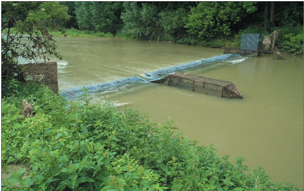
Abb. 1: Dynamisches Fischwehr an der Pielachmündung
