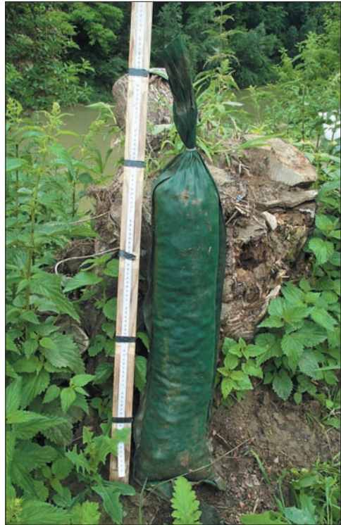
Abb. 4: Gefüllter Silosandsack zur Abdichtung des Fischwehres
