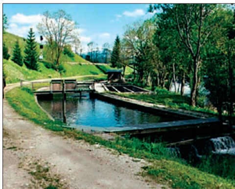
Ansicht der Hälterungsbecken im Fischereizentrum der ÖBF-Ag in Kainisch
