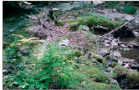
Für die Holztrift eingezwängter Bachbereich vor dem Rückbau
