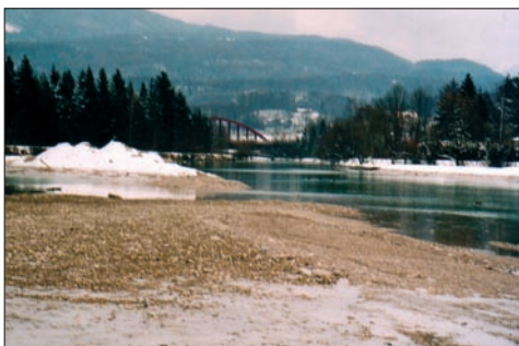
Die Errichtung von Bühnen verengt das Bett der Königsseeache, und die dadurch erhöhte Schleppkraft führt zur Beseitigung des »Schotterpfprens«
