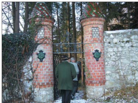
Eingang zur Quelle Andritz-Stattegg
