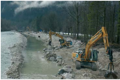
Erste Bauphase am linken Traunufer
