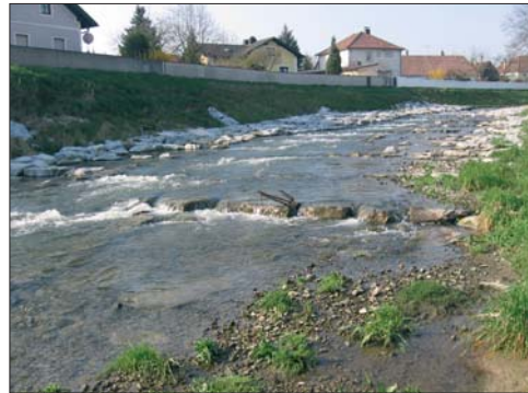
Foto 3: Ausformung einer Schwelle mit Niederwasserrinne und uferseitigen Ruhe-zonen
