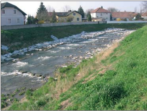
Foto 1: Ansicht der Rampe (Blick flussauf) bei Mittelwasserabfluss
