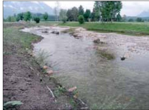
Abb. 4: Die Prallufer wurden teilweise mit ingenieurbioologischen Elementen gesichert, an den Gleituffern können sich Schotterbänke bilden.
