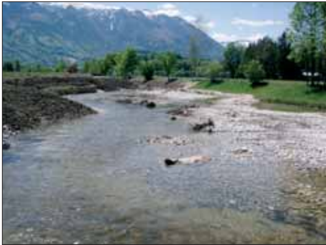
Abb. 3: Der restrukturierte Abschnitt zeigt variable Böschungsneigungen, heterogene Strömungsverhältnisse und eine Vielfalt an fischökologisch relevanten Strukturen.
