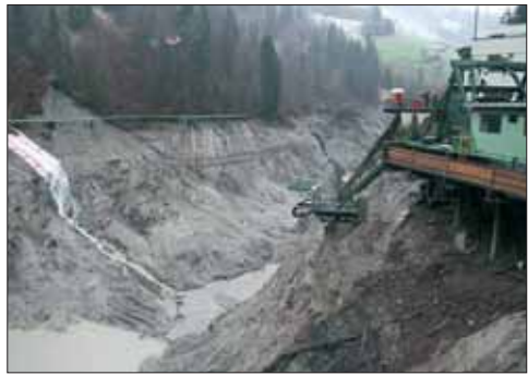
An eine Mondlandschaft erinnerte der Lutzspeicher nach der Entleerung. Wieder gelang die Freilegung der Grundablässe nicht vollständig.
