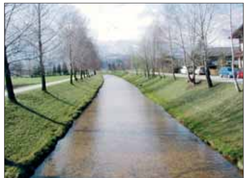
Abb. 2: Ein monotones Trapezprofil, einheitliche Gewässertiefe und Breite sowie fehlende Vernetzung mit dem Umland charakterisieren die regulierte Glan.
