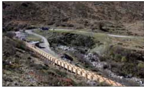
Über eine 600.000 Euro teure Holzrinne wurde klares Wasser um den Speichersee geleitet und zur Verdünnung in die belastete Ill geführt.
