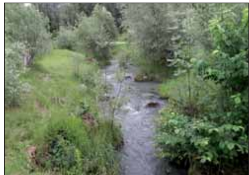
Umgehungsgerinne beim Kraftwerk Gamp bei Hallein
