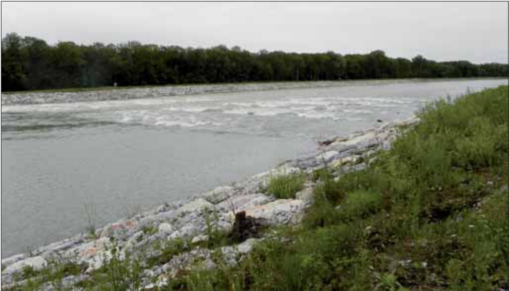
Neue Sohlrampe an der Salzach bei Fluss-km 51,9
