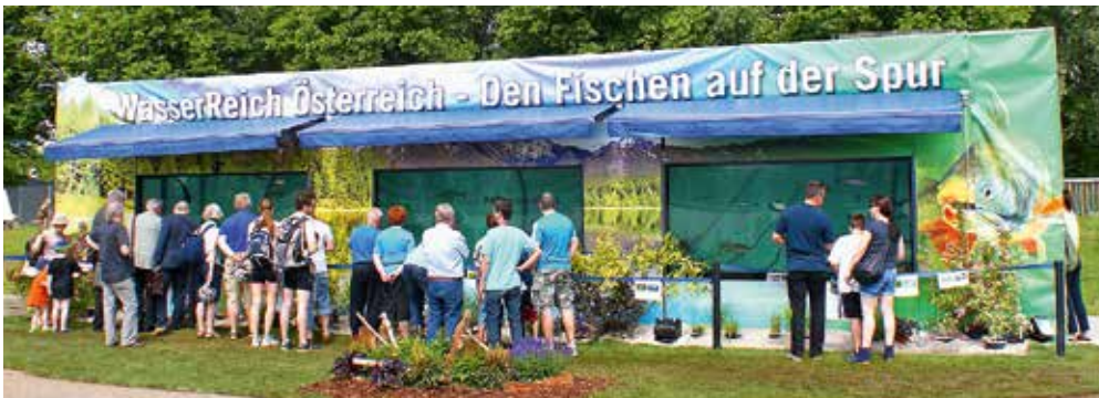
Europas größtes mobiles Aquarium: 12 m x 2,4 m x 2,6 m (L x B x H), Füllmenge 60.000 l, Gewicht leer 12 t, voll ca. 72 t, Glasstärke 60 mm. Befüllungsdauer (mit Feuerwehrschauch) 2 Std. Foto ©tiqa.at
