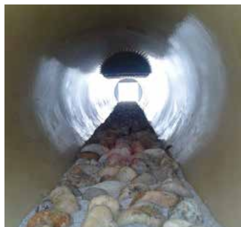
Abb. 2: Kammer mit Sohle und Feinrechen
