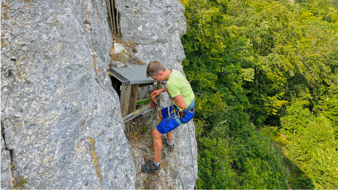
Abbildung 5: Die Installation, Wartung und Renovierung der Kunsthorste stellt noch immer eine zeitaufwändige und anstrengende Arbeit für die Mitglieder der AGW dar (Foto: A. Buck).
