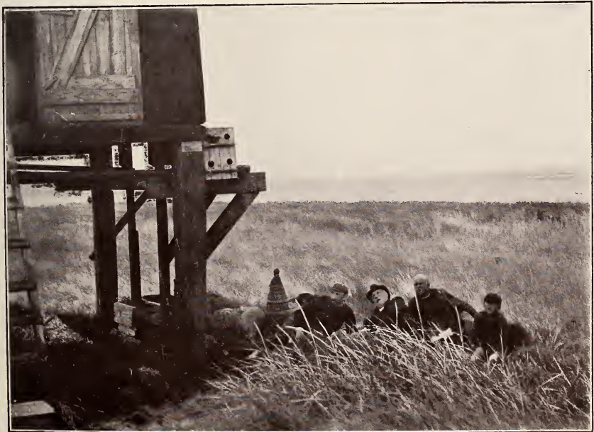
Idyll auf Norderoog. „Mietskaserne“ für Starke.
