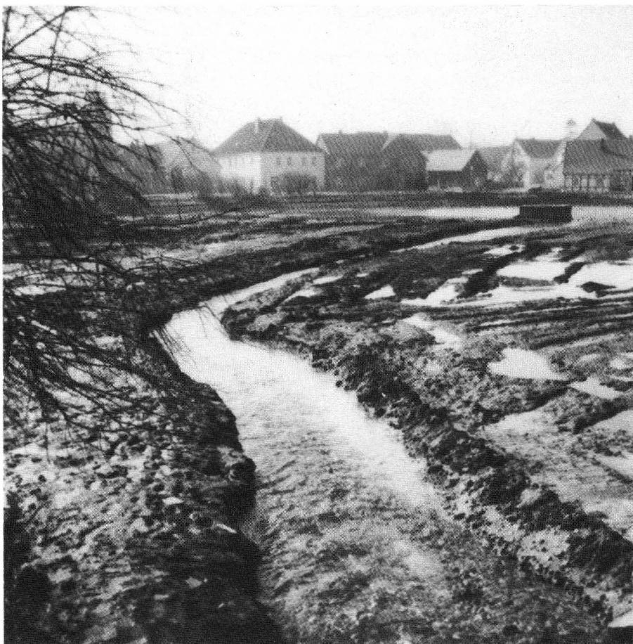
Abb. 4. Faulschlamm im Glockensee 1979
