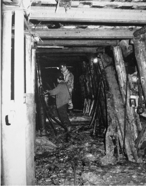
Abb. 5: Streckenvortrieb im Untertagebau Stolzenbach mit Steiger vor Ort
