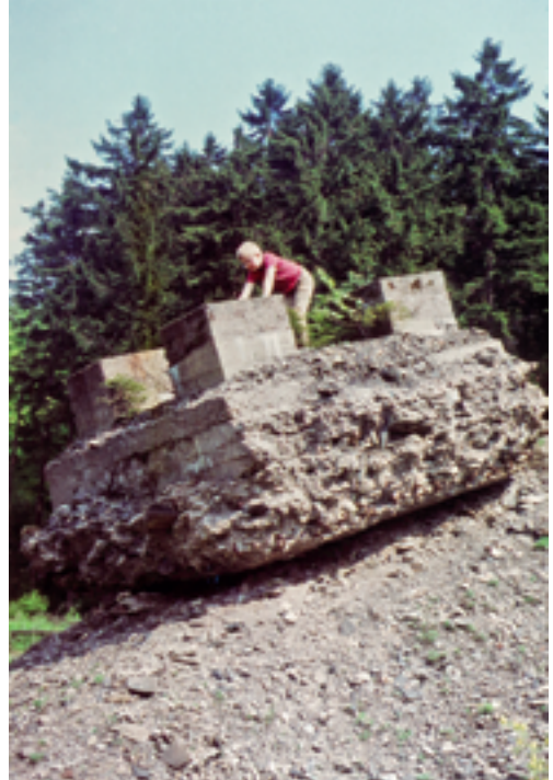
Abb. 3: Sohn Gottfried auf dem gekippten Fundament des Seilbahnmastes, Schacht Wolfsberg. Foto: G. Schaumberg.
