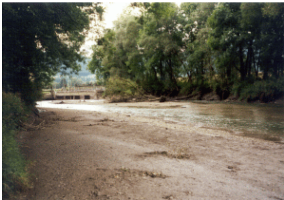
Foto 7: KW Ternitz bei Launsdorf
