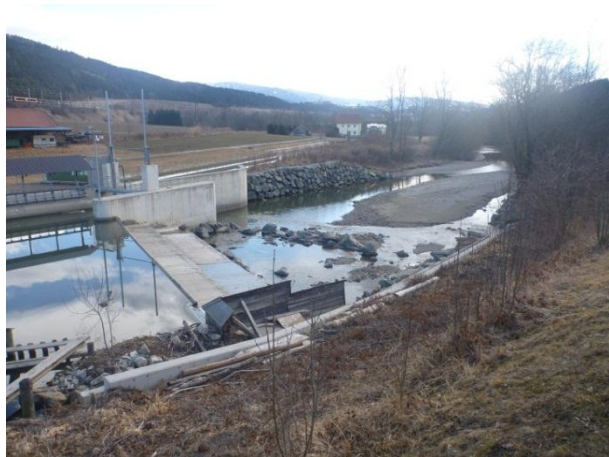
Abbildung 3: Saniertes Wehr und Fischaufstiegshilfe des Ausleitungskraftwerks in Zwischenwässern.
