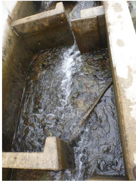
Abbildung 66: In der Fischaufstiegshilfe Zwischenwässern verkeiltes Treibgut (Foto vom 12.04.2012).
