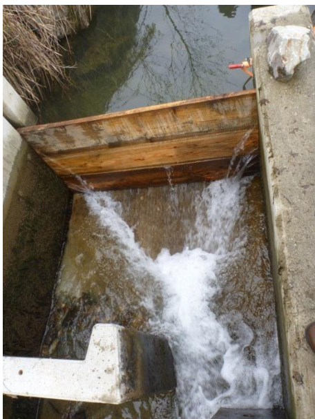
Abbildung 26: In das Einlaufbecken eingeschobene Bretter zur Absenkung des Wasserstandes in der Fischaufstiegshilfe Zwischenwässern.
