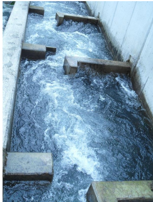
Abbildung 64: Vergleich der Strömung in der Fischaufstiegshilfe Zwischenwässern zwischen einem Becken mit kurzem und einem mit nachträglich verlängertem Umlenker.
