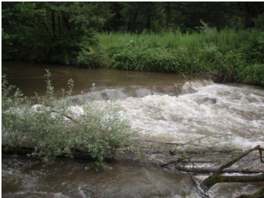
Abbildung 8: Spundwand mit 30 cm Absturz im Mündungsbereich des Triebwerkskanals Kraftwerk Rain.
