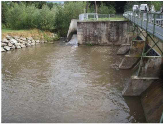
Abbildung 107: Fotodokumentation der Lockströmung von Fischaufstiegshilfe und zusätzlicher Restwasserdotation der Gurk in Rain.
