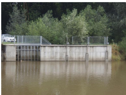
Abbildung 7: Einlaufschütze des Schlitzpasses der Fischaufstiegshilfe Rain und mit Rechen geschützter Einlauf des Dotationsbauwerks.
