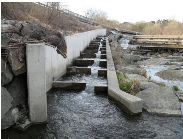
Abbildung 4: Vertical-Slot-Pass-Fischaufstiegs-hilfe Zwischenwässern am orographisch rechten Ufer der Gurk (Aufnahme am 14.03.2012)
