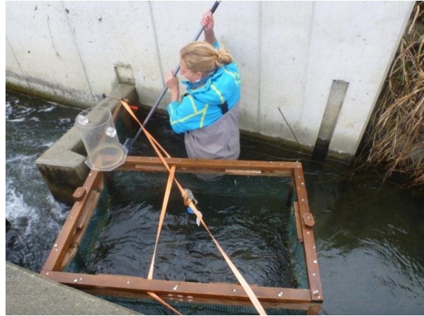
Abbildung 22: Reinigung der Reuse in der Fischeaufstiegshilfe Zwischenwässern.
