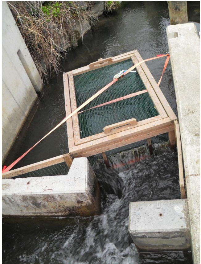
Abbildung 19: In das Ausstiegsbecken der Fischaufstiegs- hilfe Zwischenwässern eingebaute Reuse.
