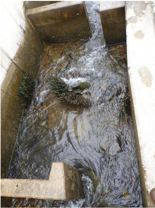
Abbildung 65: Umgebogener und mit Algen bewachsener Strömungsschutz in der Fischaufstiegshilfe Zwischenwässern (Foto vom 12.04.2012).
