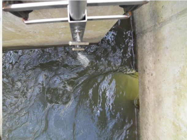
Abbildung 36: Videokamera zur Erfassung migrierender Fische im Ausstiegsbecken der Fischaufstiegshilfe Rain.
