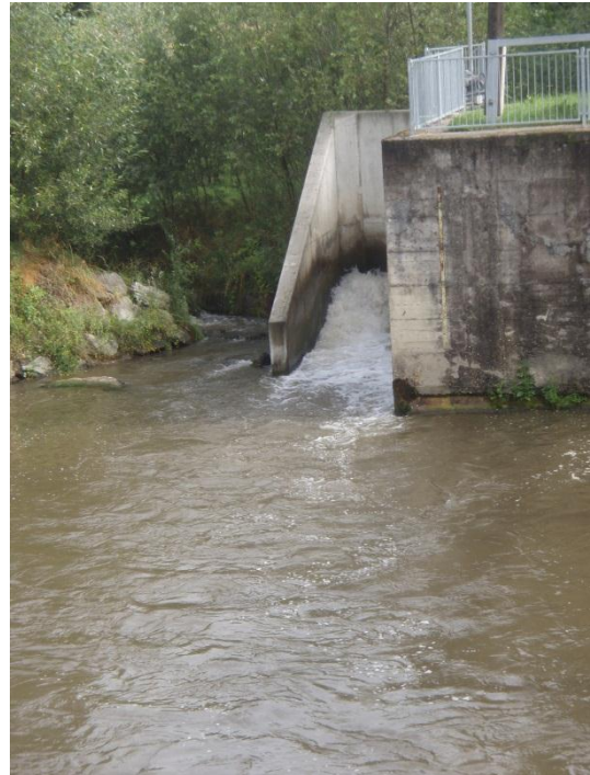
Abbildung 6: Wehrbereich des Kraftwerks Rain an der Gurk mit Dotation der Restwasserstrecke aus Fischaufstiegshilfe und Zusatzdotation.
