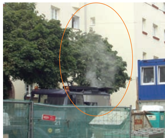
Hitzeeinwirkung durch Asphaltwagen – die Abwärme schädigt die Blätter und die Rinde des Baumes.
