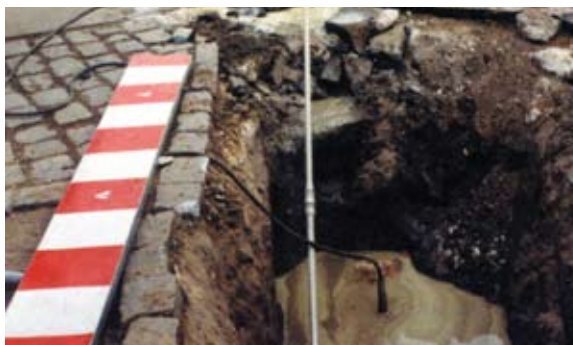
Rohrvortriebsverfahren oder Absaugen des Bodens.
