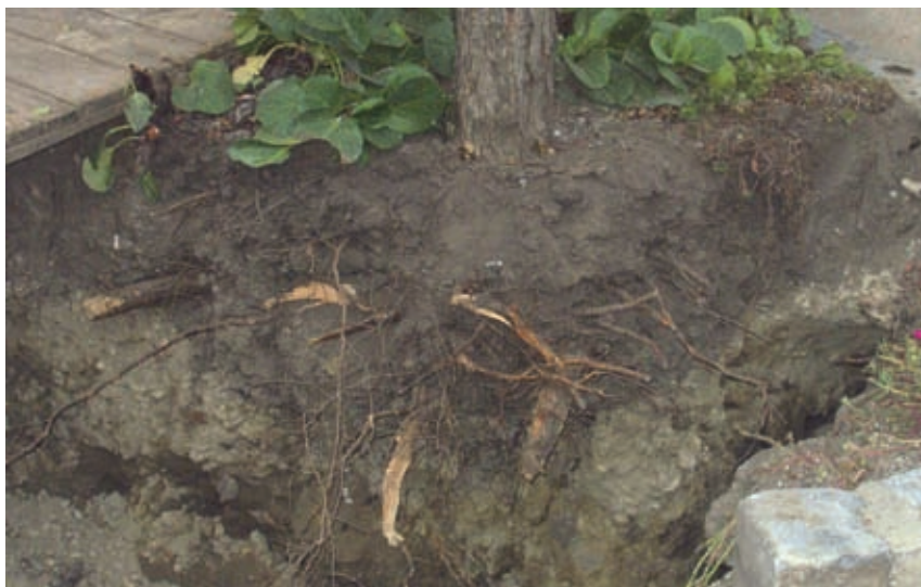
Massive Wurzelschäden durch Grabungsarbeiten.
