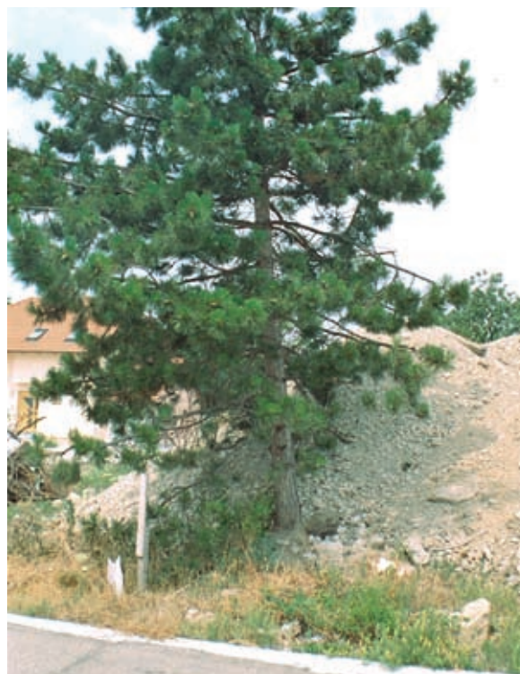
Einschüttung mit Baumaterial.
