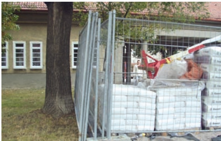
Die Lagerung von Baustoffen verursacht eine beträchtliche Verdichtung des Bodens.
