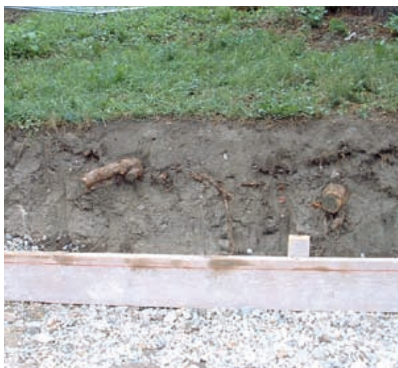
Wurzel fachgerecht geschnitten und versorgt.
