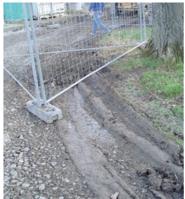
Ein Bauzaun ist schnell weggeräumt und auch wieder aufgebaut – die Reifenspuren sprechen Bände!
