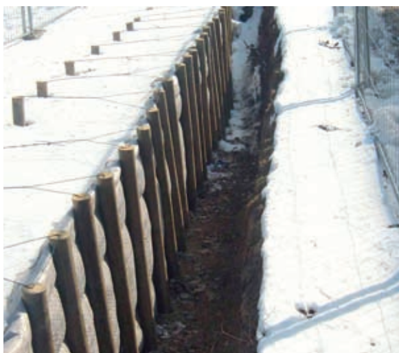
Wurzelvorhang zur Begrenzung der späteren Baugrube.
