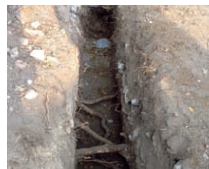
Offengelegter Graben mit Wurzeln.
