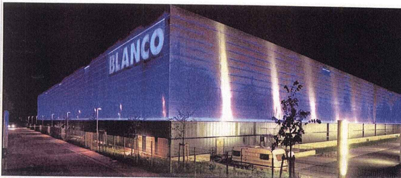
Nächtlicher Blickfang: Schon von weitem ist das neue Logistikzentrum der Firma Blanco an der Autobahn bei Bruchsal zu sehen. Etliche tausend LED-Leuchten rücken das Gebäude im Edelstahl-Design werbewirksam ins rechte Licht. Der Spülerproduzent aus Oberderdingen spricht sogar von einer Weltpremiere: Erstmals sei diese Technik einer österreichischen Fachfirma zum Einsatz gekommen, die eine hervorragende Fernwirkung bei gleichzeitig sparsamem Energieeinsatz bringe. Die Beleuchtung erstrahlt von Sonnenuntergang bis Sonnenaufgang. Je nach Luftfeuchtigkeit erscheint über dem Gebäudekubus überdies ein Lichtdom, der weithin sichtbar ist und wie eine Laserprojektion wirkt. Foto: Alabiso
