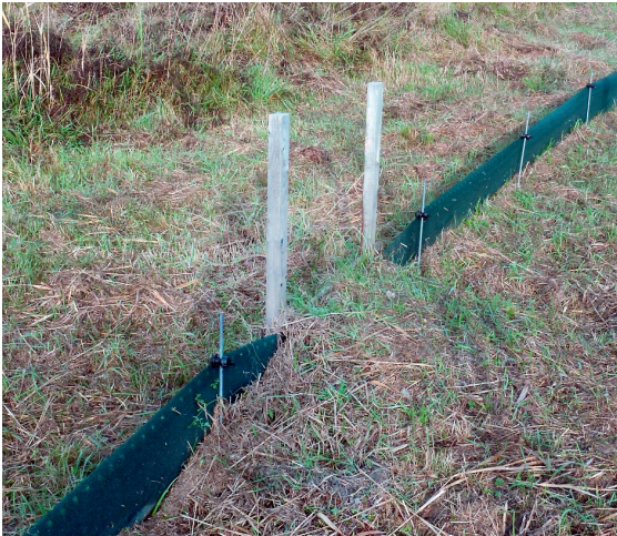
Abb. 3: Ausstiegsrampe aus anstehendem Boden mit Schalbrett verstärkt an leichtem mobilem Schutzzaun, die Ständer des Schalbrettes liegen ungünstig auf der Außenseite (Foto: JULIAN BOCK).
