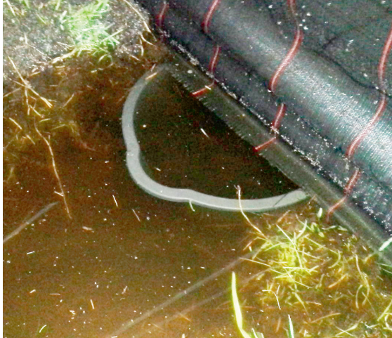
Abb.2: Verlust der Ventilfunktion durch komplettes Fluten eines Ventileimers (Foto: JÖRN KRÜTGEN).
