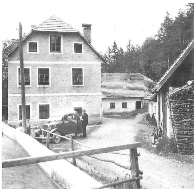
Abb. 11: Gebäude des „Jaklin-Hammers“ (1952)
