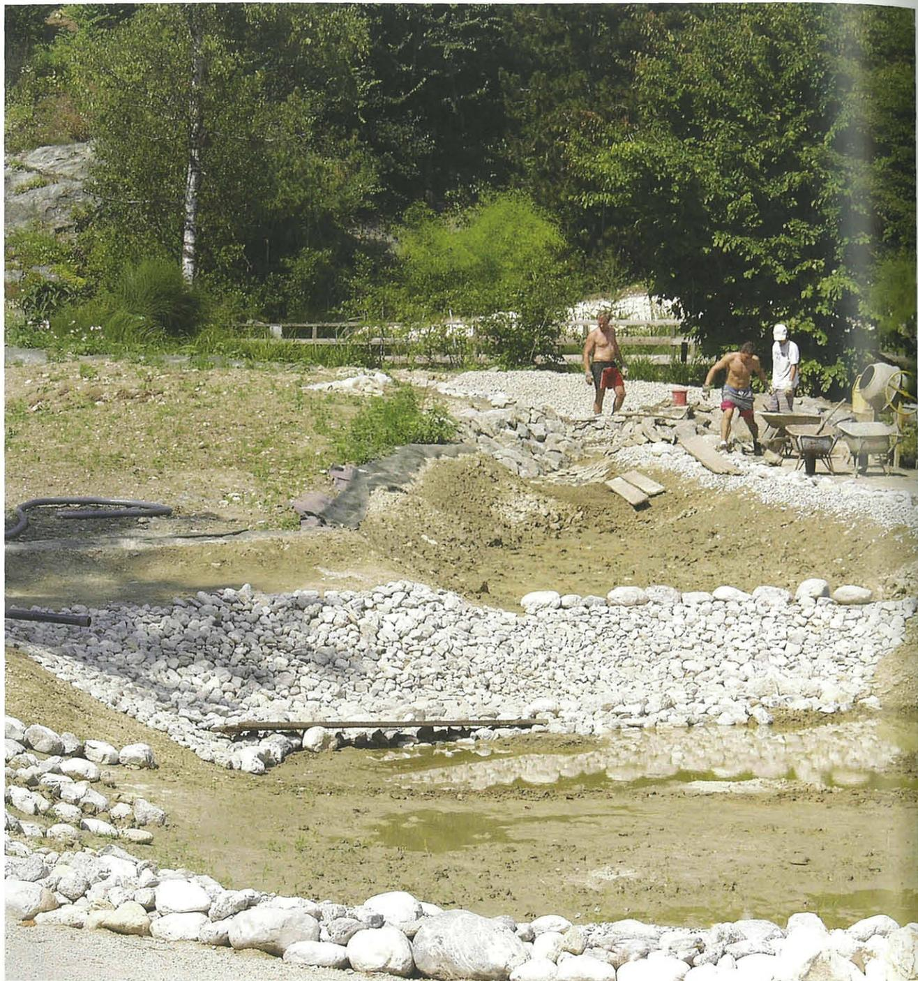
Abb. 7: In aufwändiger Handarbeit werden die Folienbereiche mit Lehm und Steinen ausgekleidet und Geländestufen zur Fixierung der Wasserstände in den einzelnen Fluss-Bereichen errichtet. Aufn. R. K. Eberwein
