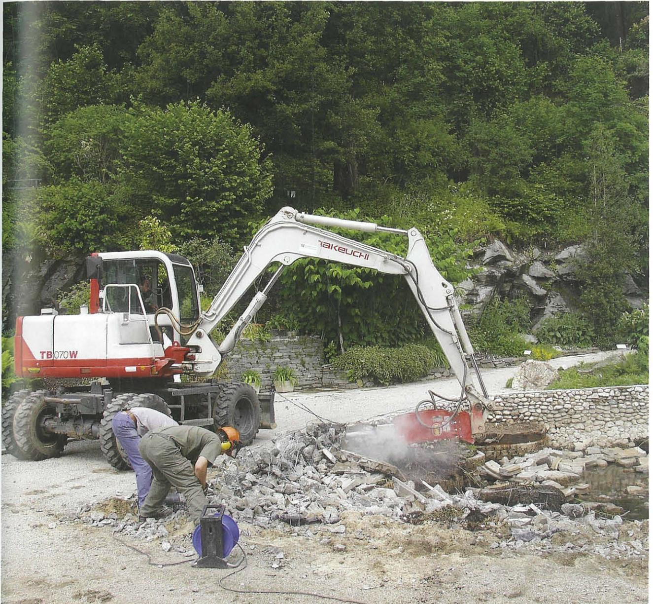
Abb. 4: Abbruch des alten Betonbeckens. Aufn. R. K. Eberwein
