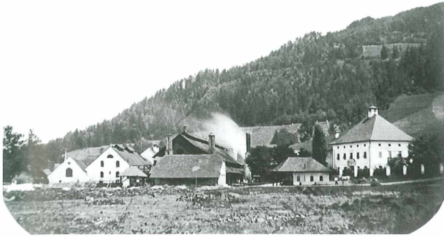
Abb. 7: Buchscheiden Eisenwerk Gesamtansicht
